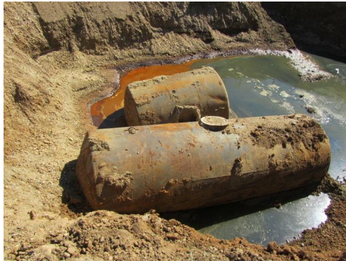
Figure 6: Vue sur les cuves inertes au béton
