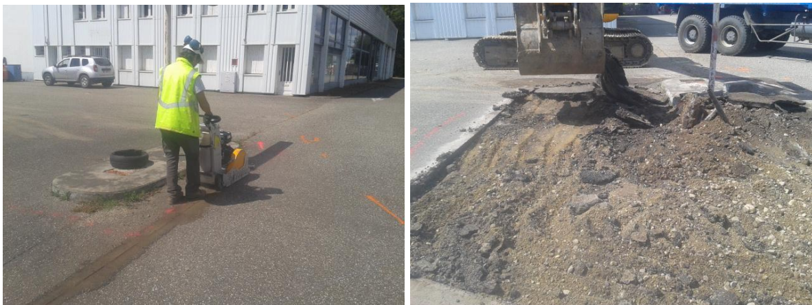
Figure 9: Vu sur la découpe et l'enlèvement de la couverture d'enrobé
