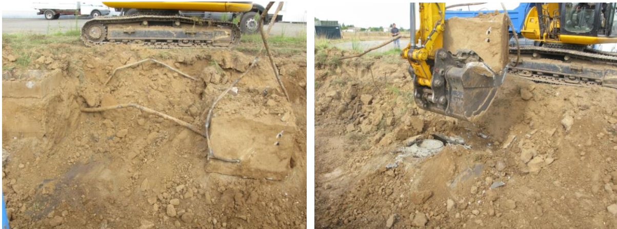
Figure 4: Vues sur les massifs bétons
