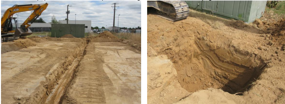
Figure 3: Vues sur la création de la plateforme d'accueil des terres polluées
